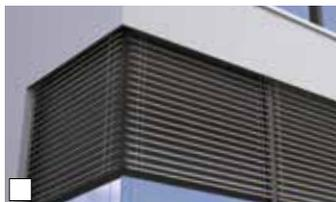
Les coupes d'angles (sciées) permettent des réalisations irréprochables. (Impossible avec lame CDL)
