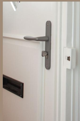
Le client a choisi l'option barillet à molette, très facile à vivre : de l'intérieur, plus besoin de clé pour verrouiller la porte. Un tour de molette suffit.
