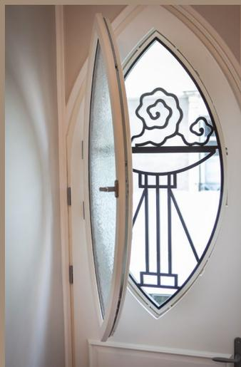
Les grilles d'origine ont été démontées, et transférées dans les usines Bel'M. Les formes de la porte et les moulures de vitrage ont été prévues spécifiquement pour recevoir ces grilles. Après une phase de restauration (sablage et laquage), assurée par nos soins, elles ont été installées, en usine, sur la nouvelle porte.
