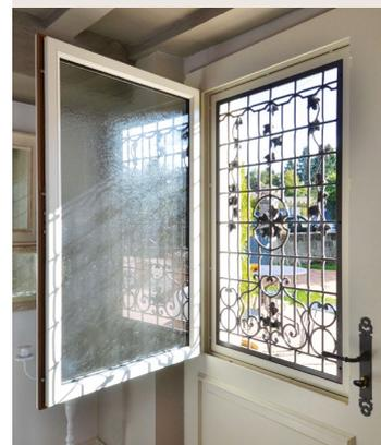
Le châssis ouvrant permet l'aération de la maison, l'identification de vos visiteurs, l'entretien de la grille et le nettoyage du vitrage.
