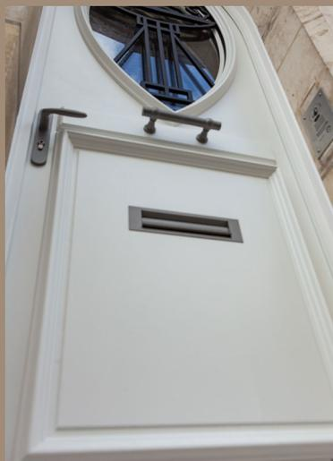
Accès sur rue oblique, l'entrée de boîte aux lettres est intégrée sur l'ouvrant, dans une finition identique à celle de la poignée et du bâton de maréchal.
