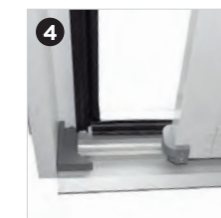
Seuil drainant en aluminium et guide d'attaque
